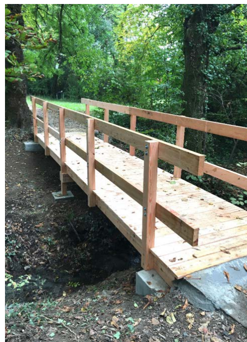
Le pont, côté ouest, entièrement refait, qui bénéficie, en plus, de meilleures fondations
